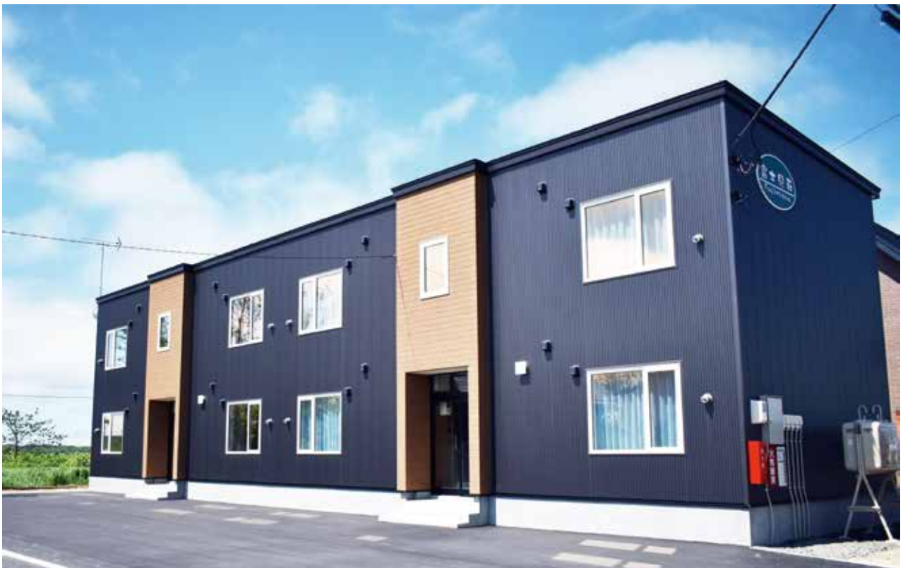
令和4年2月完成 温心園職員共同住宅「富士見荘」
